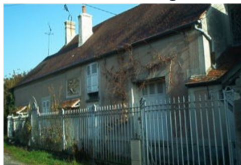
Maison d'Albert Grenier à Montaigu
